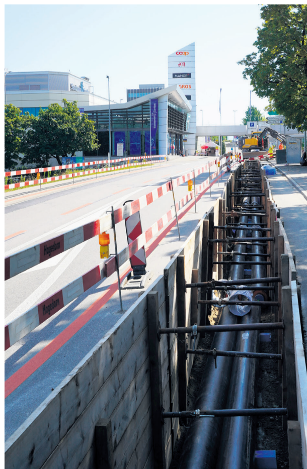
Fernwärmeleitungen (Vor- und Rücklauf) entlang der Gwattstrasse in Pfäffikon.
